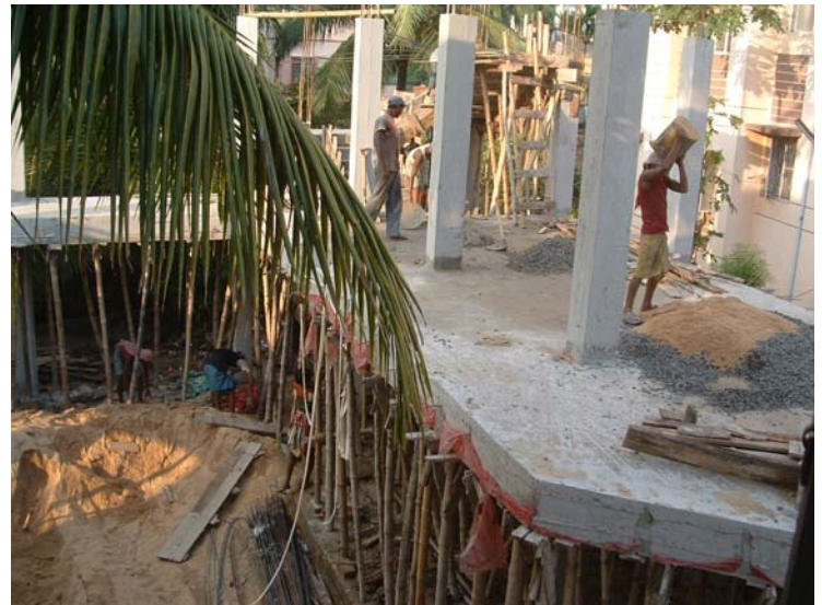
Bauarbeiten am Ostflügel
