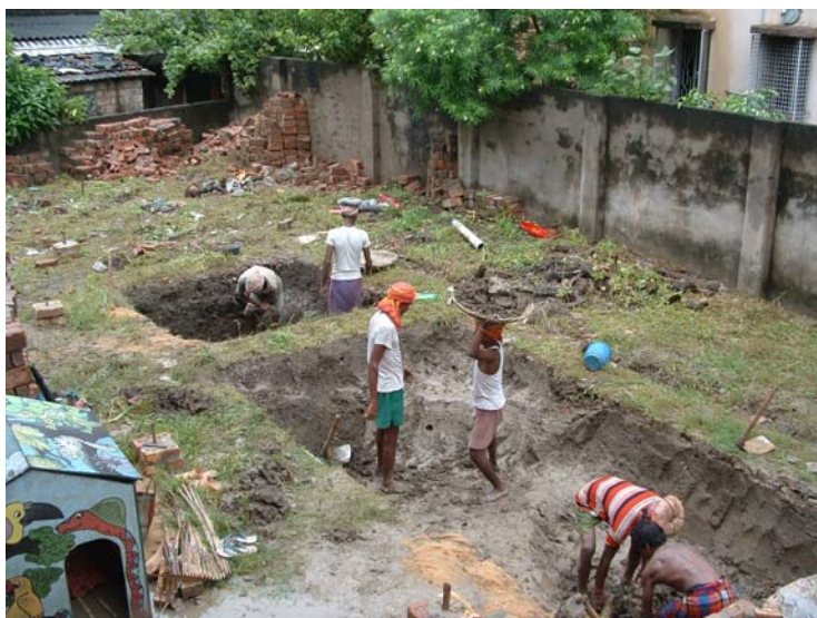
Erdaushub für den Ostflügel
